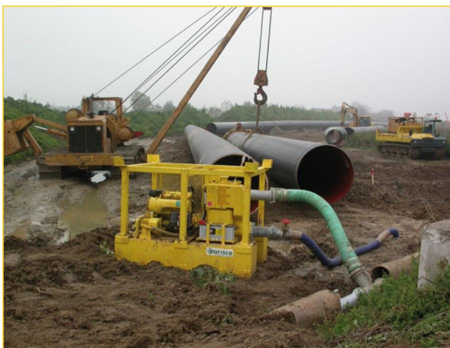
Drainage des fouilles pour la pose de canalisation
